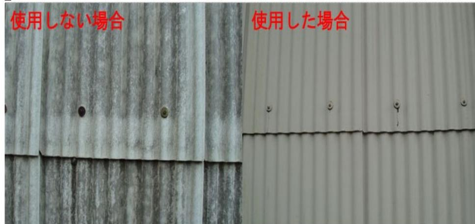
タイフロン溶剤性タイプを塗装していない場合の「石綿スレート壁面」はカビと劣化が著しいが、使用しておいた「石綿スレート壁面」真新しいままで健在。
