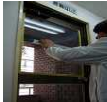
ガン吹き工法
