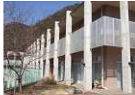
岡山県備前市 特別養護老人ホーム
