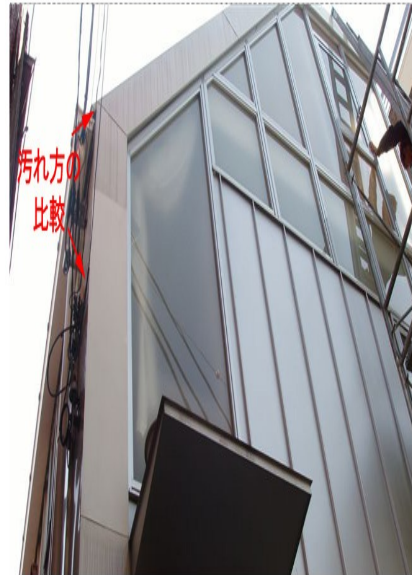
■ガルバリウム面の汚れ方の比較写真
