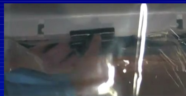
クリップ ST-210 を用いて 隙間なく取り付ける
